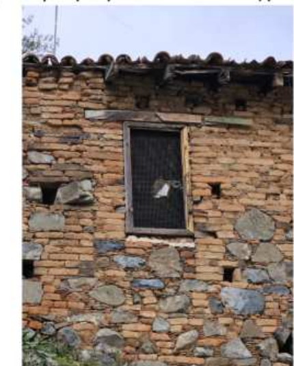
Παράθυρα με μεταλλικό πλέγμα
